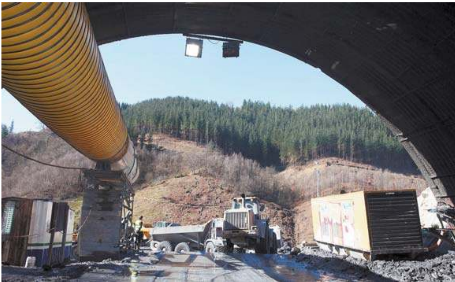
Boca del túnel de Ordizia-Itsasondo, con la enorme tubería que depura el aire del interior, donde se han perforado 1.600 metros. :: FRAILE
